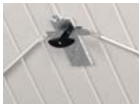
Zamek z wkładką ryglującą bramę dwustronnie
